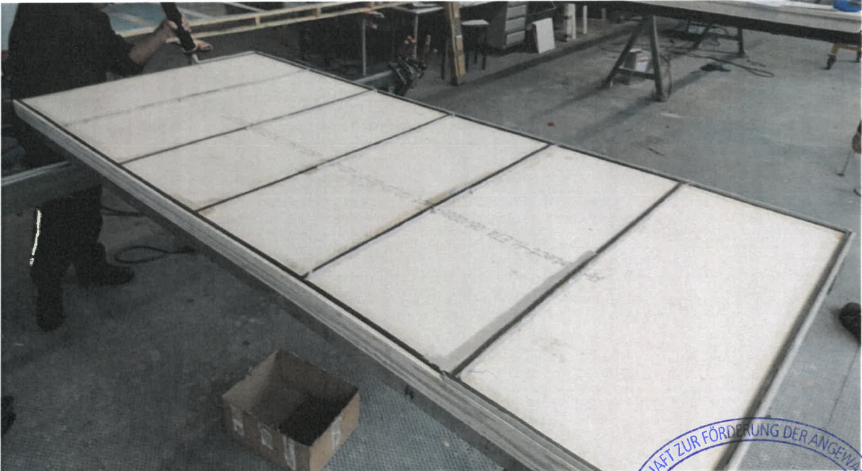
Bild 4: Herstellung des Panels. Aufbringen des Klebers
